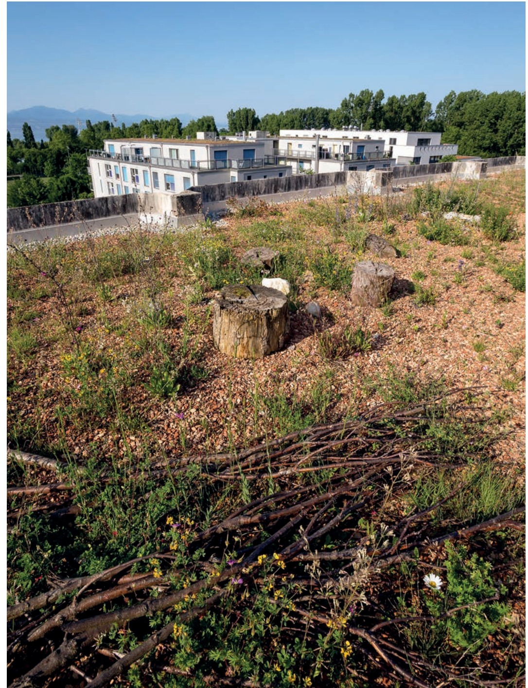
| Patience ! La végétation mettra au moins deux ans pour prendre ses aises en toiture. La présence de quelques plages de sol nu n'est pas un problème, au contraire : elles contribuent à la diversité du site. |
